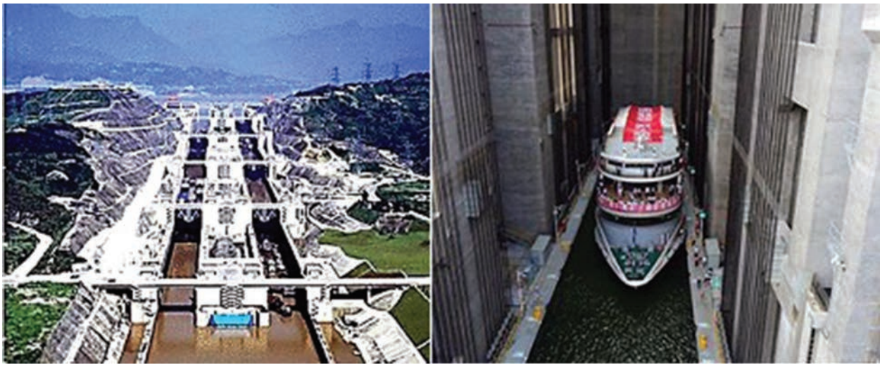
Рис. 10. 5-ступенчатый шлюз (слева) и лифтовый подъемник судов (справа). Источник: https://www.yangtze-river-cruises.com/yangtze-river-guide/three-gorges-dam-ship-lift.html
