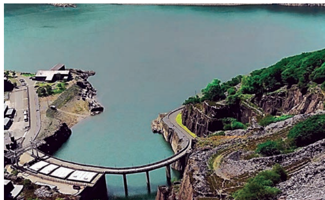
Рис. 18. Нижний резервуар станции «Динорвиг». Источник: https://www.theregister.co.uk
