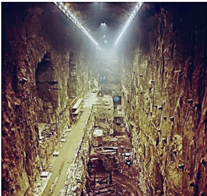
Рис. 22. Строительство полости машинного зала станции «Динорвиг». Источник: http://www.electricmountain.co.uk/Gallery
