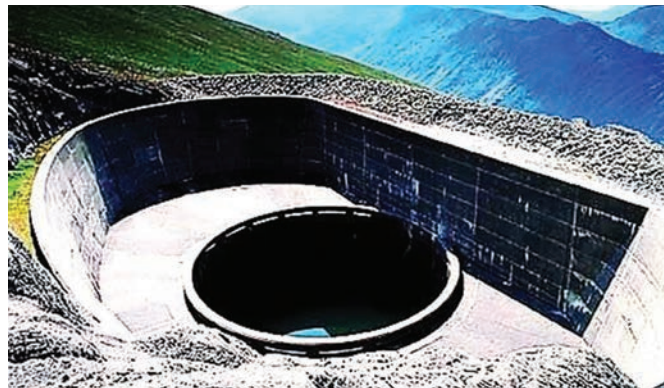
Рис. 19. Буферный пруд комплекса «Динорвиг». Источник: http://www.chesterart.co.uk/dinorwig/dinpres/surgepond.htm
