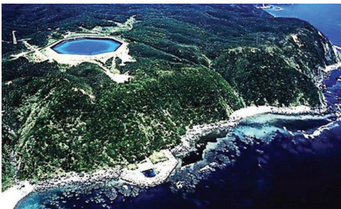
Рис. 26. Станция «Окинава»: верхний искусственный резервуар и место сброса воды в море. Источник: http://blogs.worldwatch.org/revolt/pump-up-that-seawater-a-remix-to-pumped-storage...
