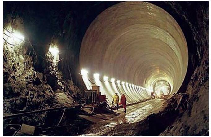
Рис. 23. Участок крепления туннеля комплекса «Динорвиг» металлической крепью. Источник: https://www.theregister.co.uk/2016/05/16/geeks_guide_electric_mountain/
